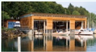
Stützpunkt Spiez 6 Taucher/Schiffsführer mit Seepolizei- und Kantonspolizei- Hauptaufgaben
